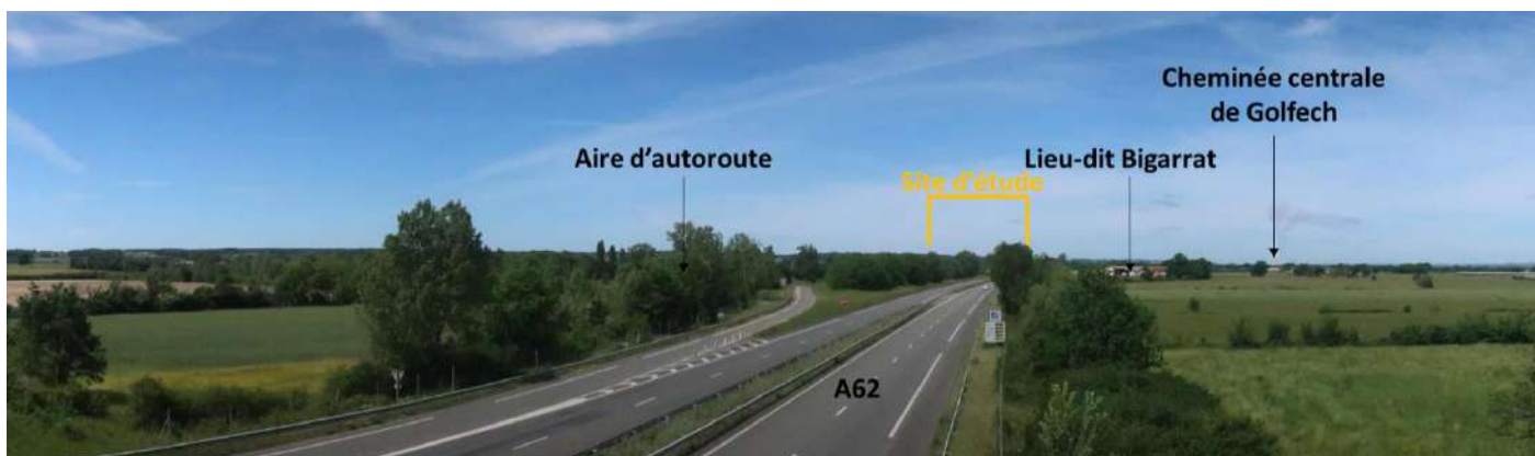
5 – Vue depuis le pont de l'autoroute A62 à l'Est
